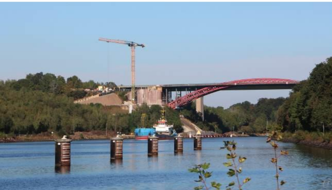
Die Levensauer Hochbrücke markiert aktuell die engste Stelle des Nord-Ostsee-Kanals. Durch den Neubau wird hier zukünftig kein Nadelöhr mehr sein.
